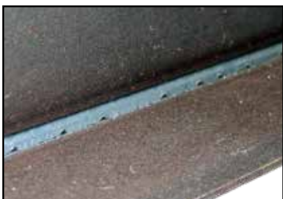
■ Saldatura a gola acciaio PB 8,0 mm | FOCUS.ARC
